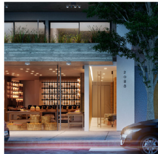
TRESOR V LAS HERAS 2088
